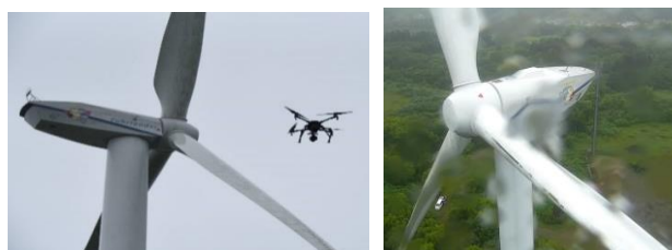
図1 空中ドローンでの撮影状況とドローンからの映像
